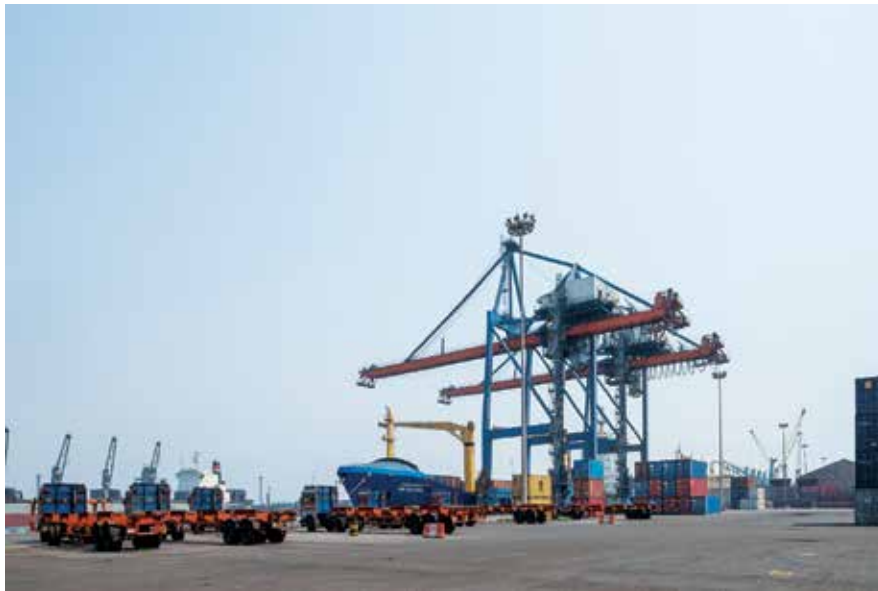
एचडीसी के कंटेनर टर्मिनल पर आर एम क्यू सी परिचालन RMQC operation at Container Terminal at HDC
