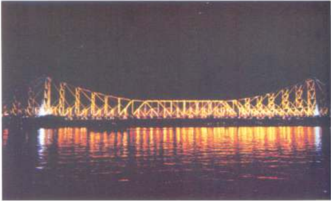
हुगली नदी पर अवस्थित हावड़ा पुल का एक दृश्य A view of Howrah Bridge on river Hooghly
