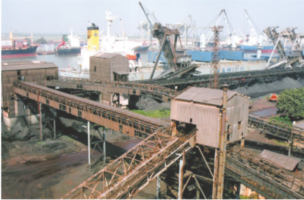
हल्दिया गोदी परिसर में कोयला संचालन संयंत्र Coal Handling Plant at Haldia Dock Complex
