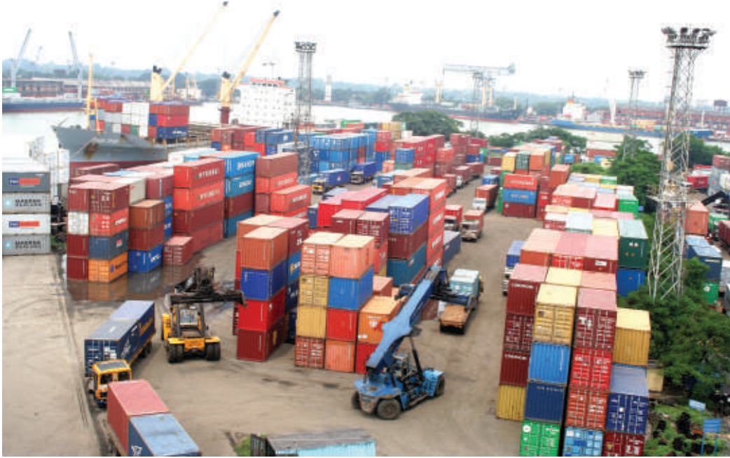
नेताजी सुभाष डॉक, कोलकाता पर कंटेनर टर्मिनल Container Terminal at Netaji Subhas Dock, Kolkata
